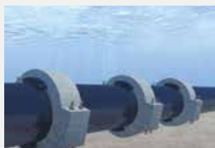
Buter les éléments de lestage d'un tube
