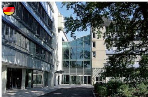
Usine d'Ingelfingen (DE) Production d'électrovannes et de systèmes
