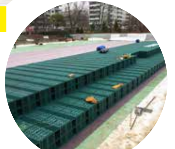
Rigofill inspect ☺ Petit Lancy (Suisse)
