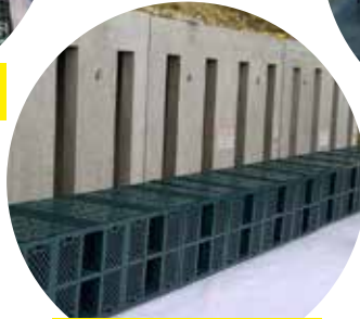
Rigofill inspect galerie béton ☺ Vichy (03)
