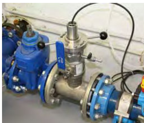
Montage de la Turbimax CUS52D sur conduite. Photo prise à Fislis.
