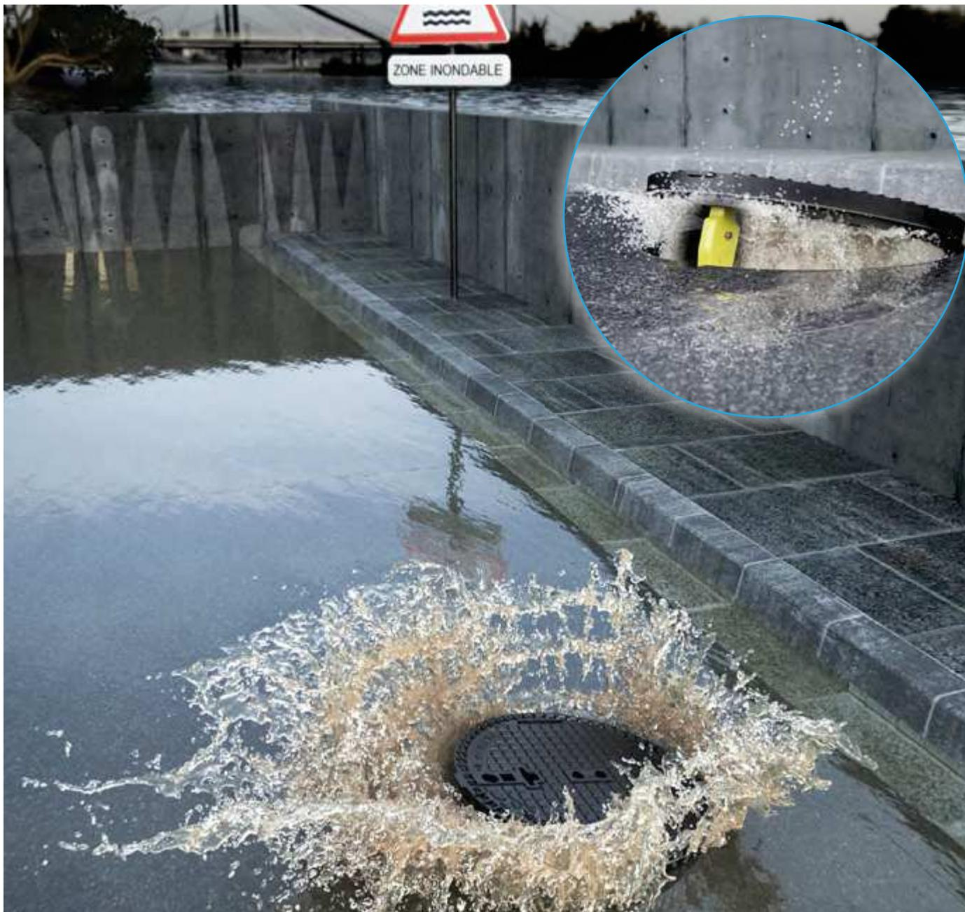
Lors d'une pluie ou d'une marée majeure, la pression de l'eau à l'intérieur des réseaux peut être suffisamment puissante pour forcer et déloger un tampon de voirie, créant de sérieux dangers pour les automobilistes et les piétons.
