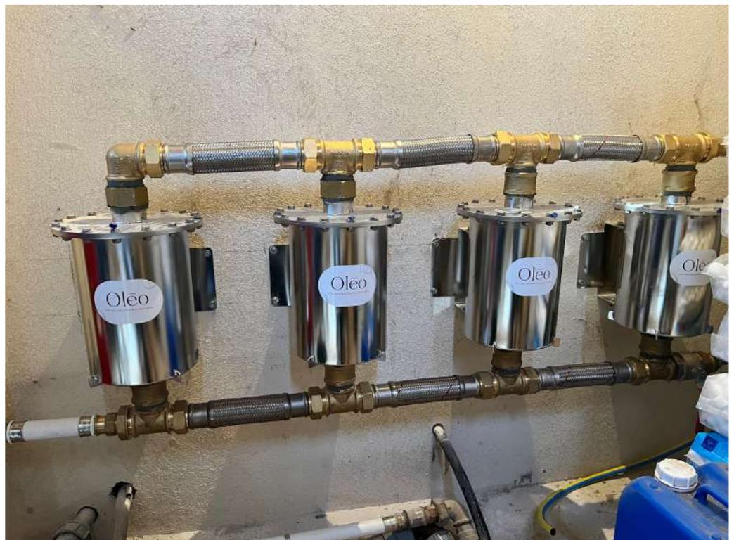
Quadruple OLÉO800 (Entrée/sortie en 2 pouces)
